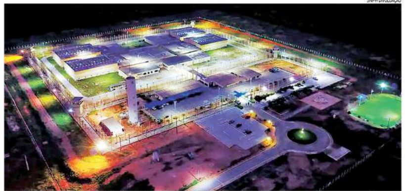
O presídio de Mossoró, no Rio Grande do Norte, foi a primeira unidade federal a registrar fuga de presos. Unidade passava por reforma
